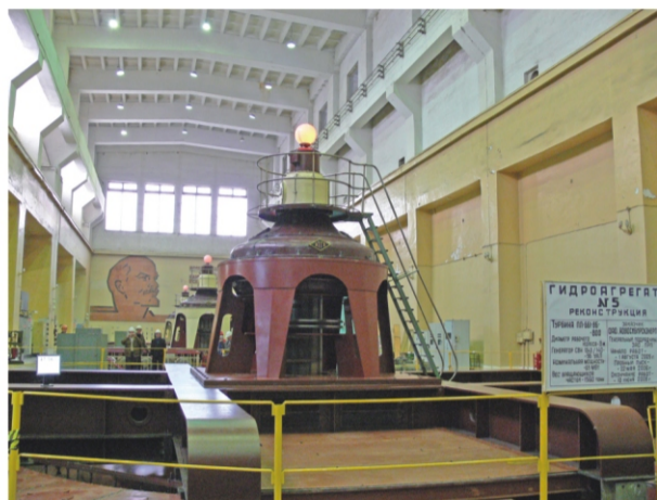
▲ У пятого агрегата новая трудовая жизнь
